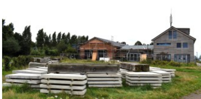
Hier lagern Materialien für den Außenbereich des NBZ, der Fortschritt beim Wiederaufbau dahinter ist gut zu sehen.
